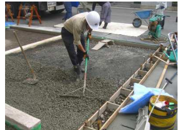
④レーキ敷き均し
