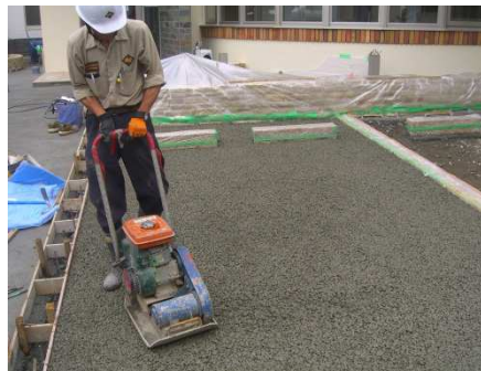
プレート転圧
