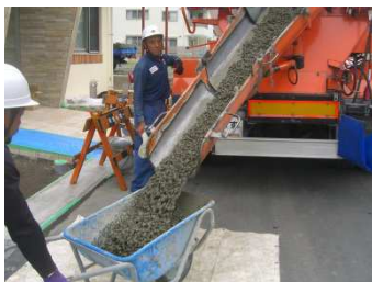
②生コン車より受け取り
